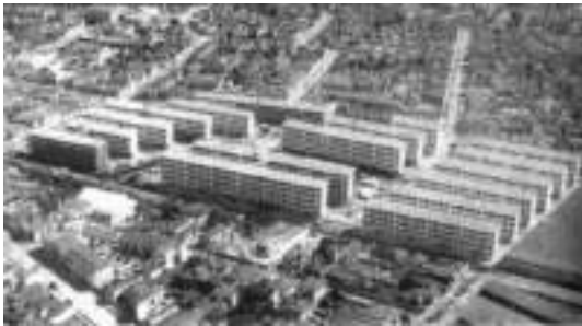
Figura 9 – Vista geral do conjunto Fonte: BONDUKI; KOURY. 2014. v. 2. p. 42
